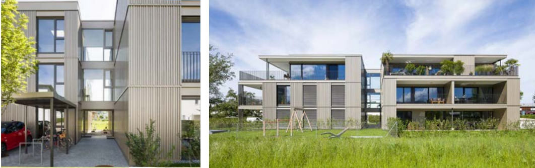
Wohnanlage Gartenstraße 16 | Wolfurt
