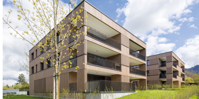
Wohnanlage Wuhrstraße 3 + 5 | Hörbranz
