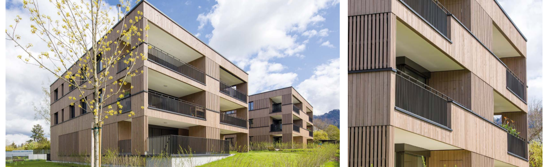
Wohnanlage Wuhrstraße 3 + 5 | Hörbranz
