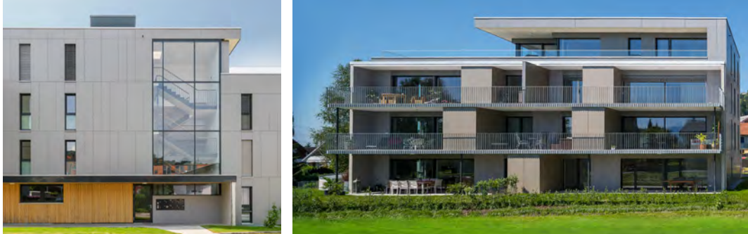
Wohnanlage Apfelgasse 1 + 1a | Schwarzach
