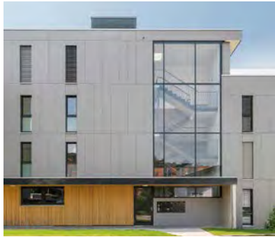
Wohnanlage Apfelgasse 1 + 1a | Schwarzach
