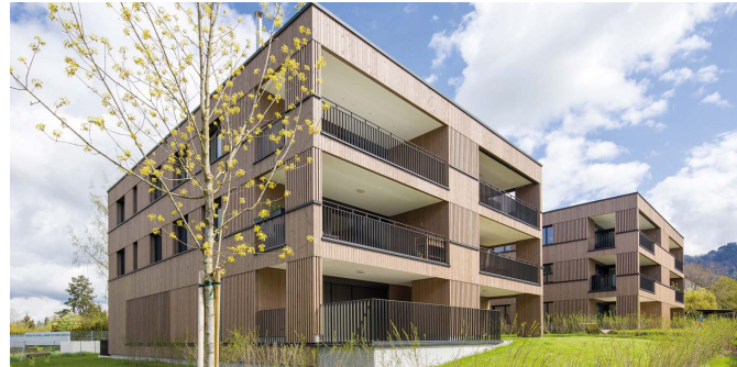
Wohnanlage Wuhrstraße 3 + 5 | Hörbranz
