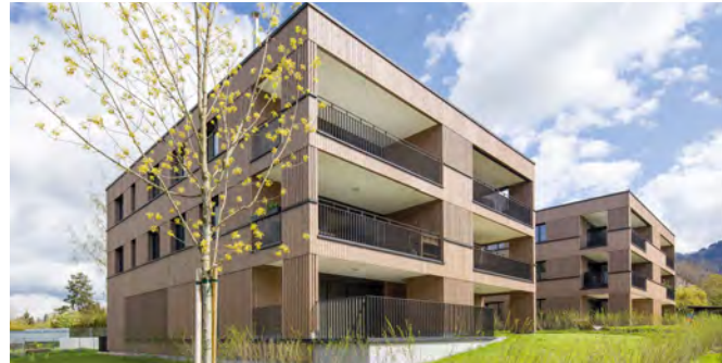
Wohnanlage Wuhrstraße 3 + 5 | Hörbranz
