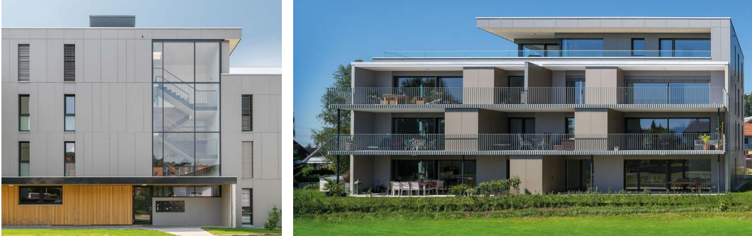
Wohnanlage Apfelgasse 1 + 1a | Schwarzach
